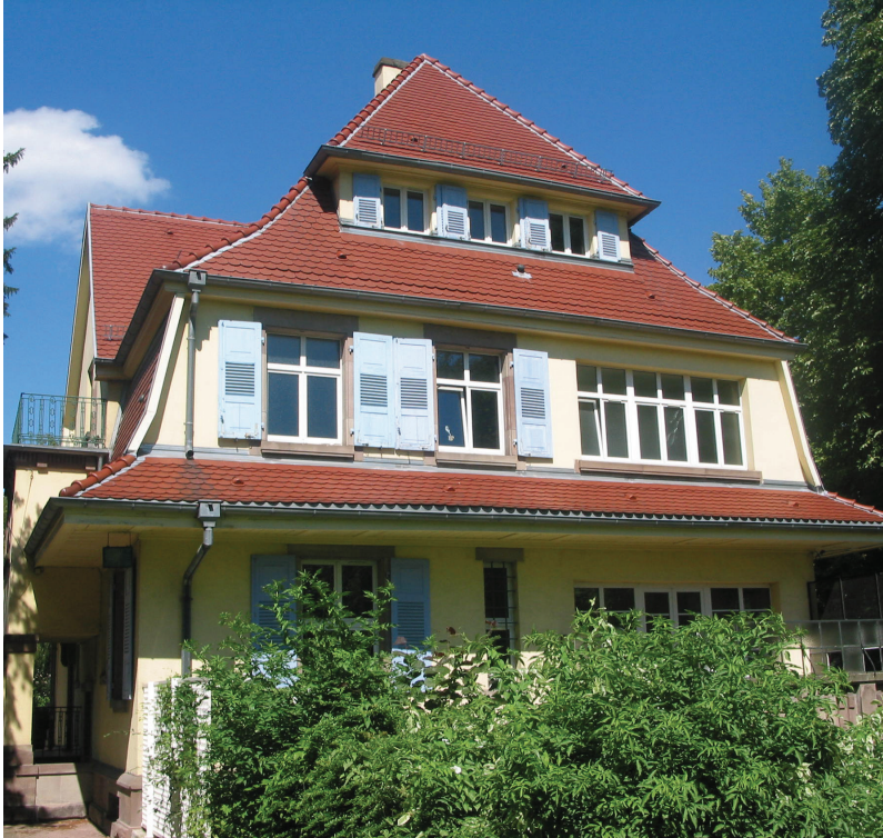
Bâtiment de l'administration
