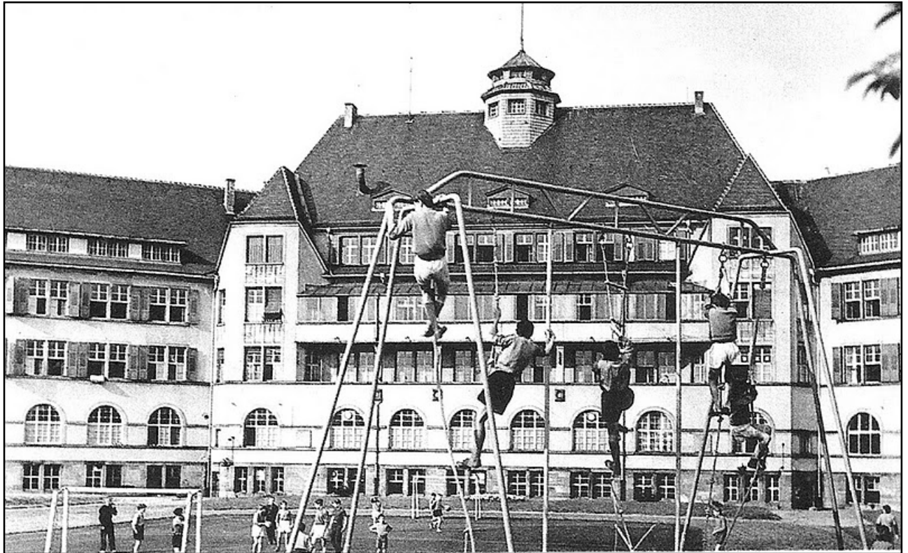
La façade arrière du bâtiment avec ses 2 ailes et le terrain de jeux.
