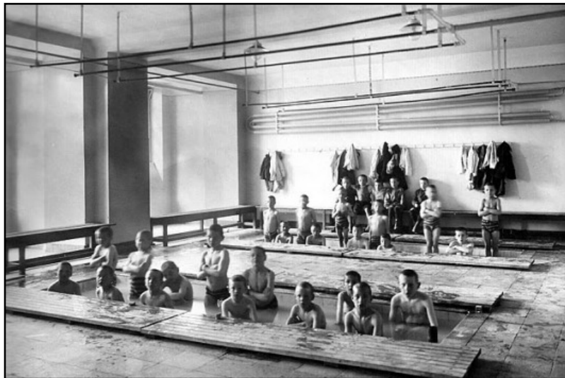
La salle des douches composée de 2 bacs surplombés de tuyaux arroseurs.
